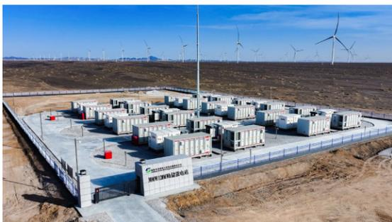
本项目共交付24个南都Center L Plus 20尺5MWh+液冷储能系统,从生产、集成到完成发货仅用19天。液冷储能集装箱搭载了南都酒泉基地自研自产的314Ah电池,该款电池在保持12000次循环寿命和长达20年电池寿命优势的同时,单体能量超过1000Wh,体积能量密度超过390Wh/L。
